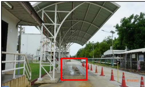
รูปที่ 2.1-3 เครื่องขังรถบรรทุกก่อนออกนอกโครงการ
